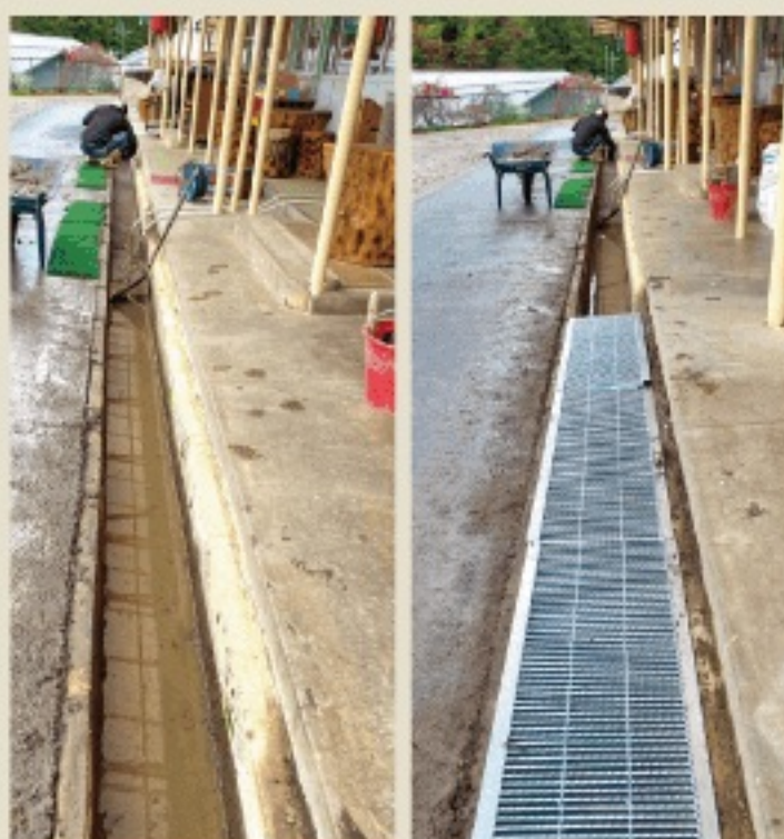
側溝蓋の改修で安全に
